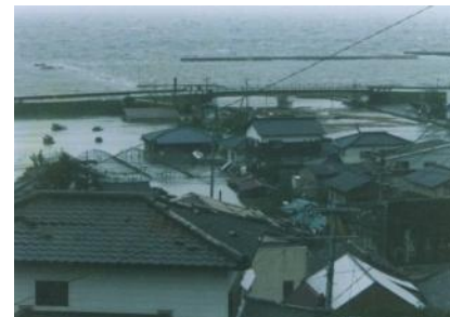
高潮による被害写真
